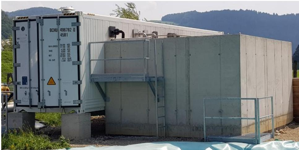
Abbildung 1: MBR-Großanlage: Betriebscontainer und Biologiebecken
