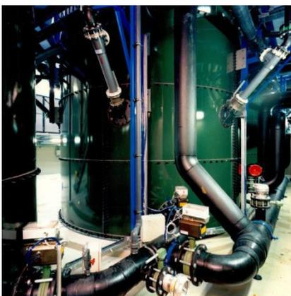
Damit die Mikroorganismen optimale Milieuverbindungen vorfinden, bedarf es einer intensiven Vermischung und Versorgung mit ausreichend Sauerstoff.
