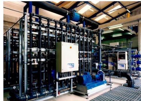
In einem letzten Schritt wird das Sickerwasser mittels Umkehrosmose zu Reinwasserqualität aufbereitet.
