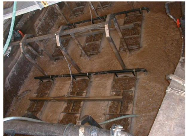
Abbildung 1: Module tauchen in das Membranbelebungsbecken ein
