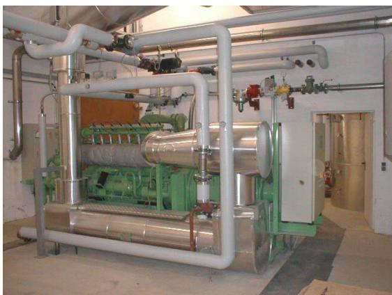
*slika 2: razgradna naprava (zgoraj) in kogeneracijska naprava (spodaj)*
