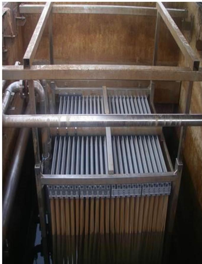
Abbildung 3: Abwasseraufbereitung in der Pharmaindustrie (Gruber, 2017)
