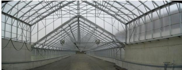
Abbildung 4: Solare Klärschlamm-Trocknung
