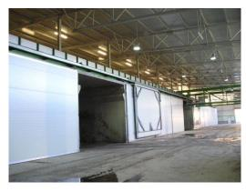
Die Rotteboxen sind geschlossen, so dass im Normalbetrieb keine Emissionen aus den Boxen entweichen. Lediglich beim Befüllen und beim Entleeren der Boxen müssen diese geöffnet werden.
