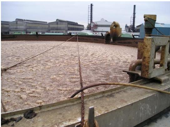
Die getauchten Membrane werden entweder in einem getrennten Behälter eingebaut oder direkt in den belüfteten Belebtschlammbehälter getaucht.
