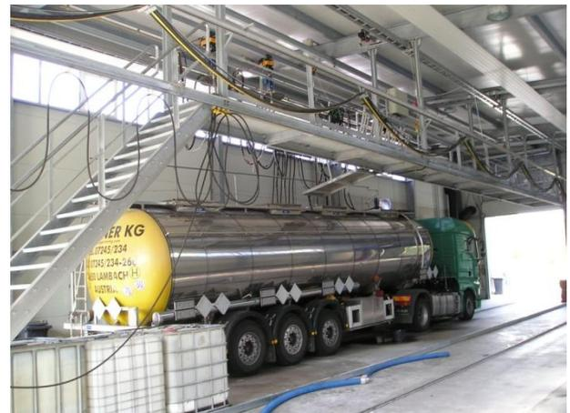
Die Steuerung der Tankinnenreinigung erfolgt über ein Computersystem. Dieses regelt, entsprechend den Reinigungsanforderungen des jeweiligen Inhaltsstoffes, automatisch die Zugabe von Reinigungsmittel, die Dauer der Reinigung und des Spülschrittes.
