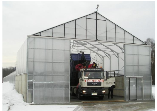
Abbildung 4: Einfahrtbereich der Trocknungshalle
